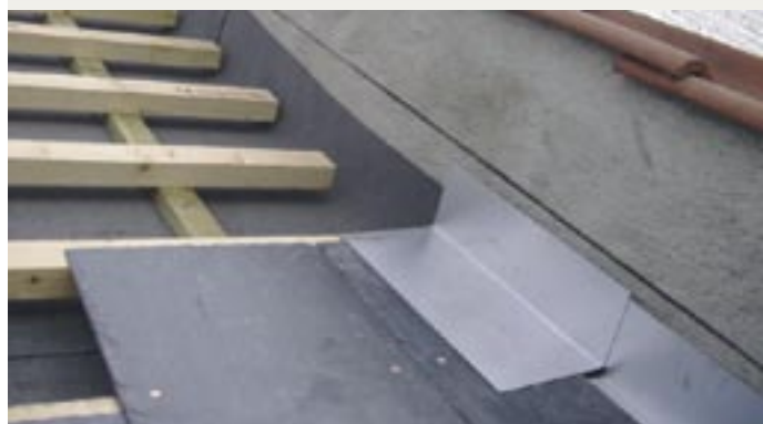
▲ (63) Traditionelt udført inddækning ved skifertag
