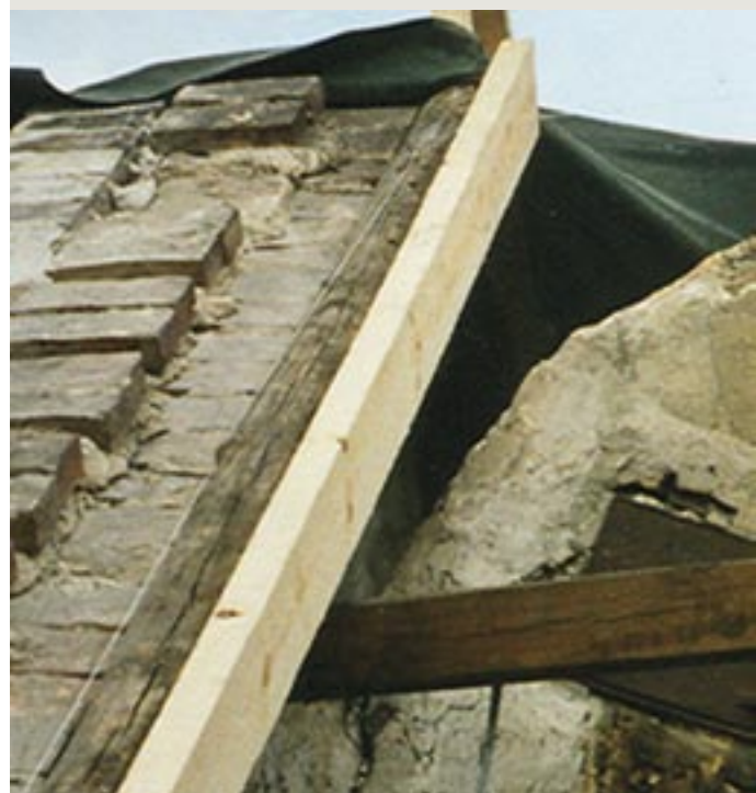
▲ Opretning af spær med planker på siden
