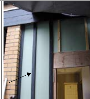
FOTO NR. 2: Underlag for udv. facade - debeklædning
