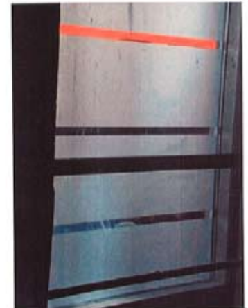
billed 4 vinduer i cykelkælder pudses indvendigt
