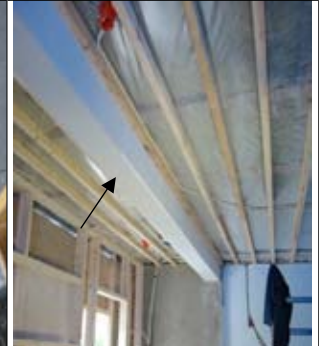
FOTO NR. 6: Brandsikring af jern - bjælke m. 25 mm fireboard.
