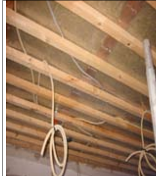
FOTO NR. 4 : Forskallingsunderlag pr. 30 cm for loftsbeklædning.
