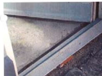
billed 3 Dør til cykelkælder: dørtrin udstøbes
