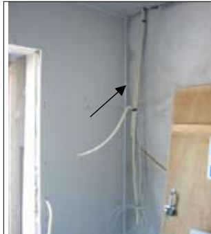
FOTO NR. 1: Beklædning af facade - væg - fugetætning inden andet lag
