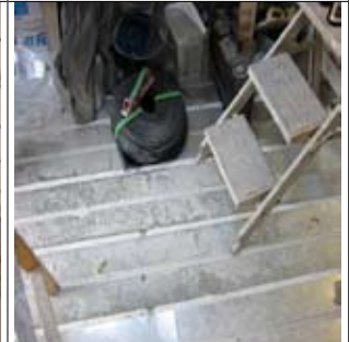
FOTO NR. 9: Varmeplader udlagt på flamingoplader inden gulve.
