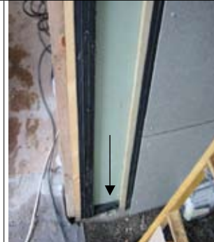
FOTO NR. 5 : Insektbånd indlagt mellem forskalling.
