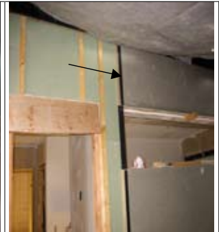
FOTO NR. 3: Ny facadebeklædning
