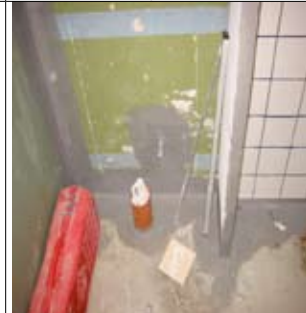
FOTO NR. 8: Vådruksbehandling samt fliseopsætning.
