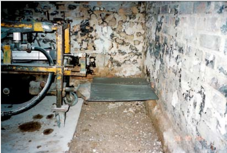
Indvibrering af stålplader Skader efter indvibrering
