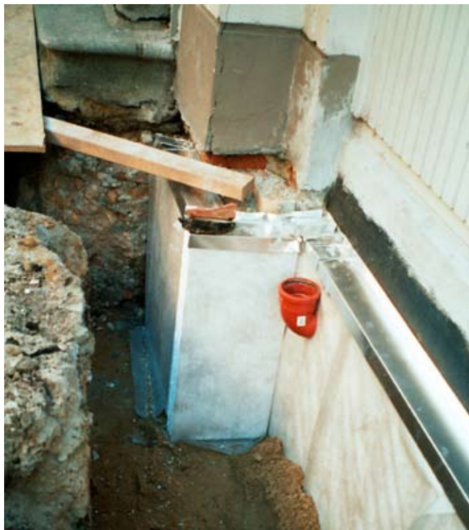
Udvendig fugtisolering
