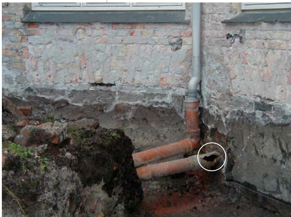
Fugt i kældre kan komme fra flere forskellige kilder, fx utætte afløbsledninger.
