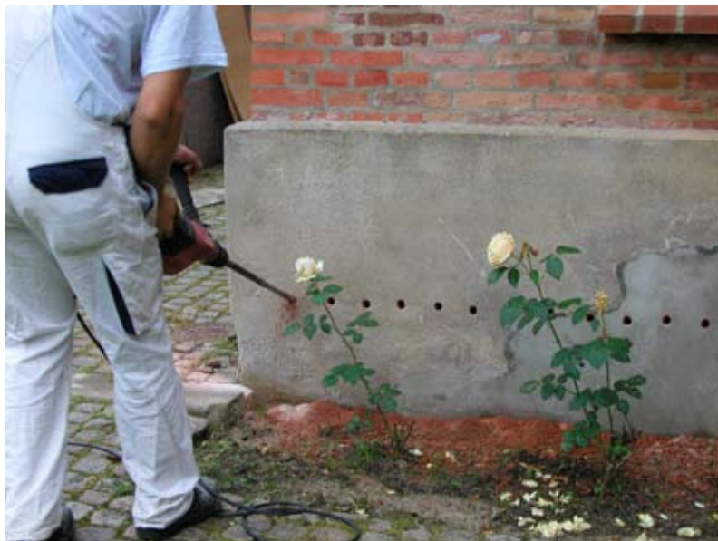
Forberedelse til kemisk fugtbremning
