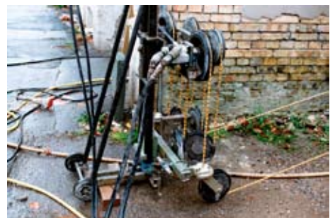
Savning af spalte med wiresav
