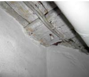
Træbjælkelag over kælder.
