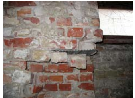
Indvibrering af stålplader Skader efter indvibrering
