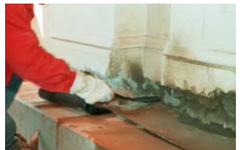
Ilægning af membran i spalte
