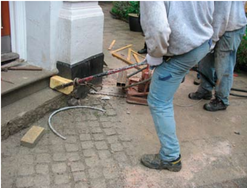
Savning af spalte med kædesav
