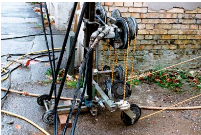
Savning af spalte med wiresav
