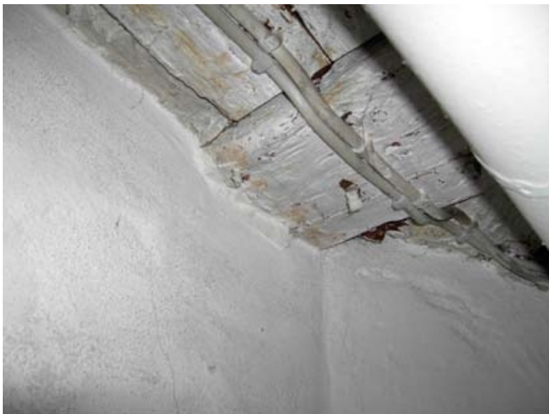
Træbjælkelag over kælder.
