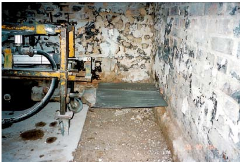
Indvibrering af stålplader
