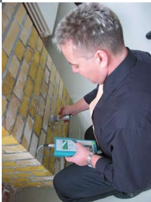
Fugtmåling med HF sensor metoden (mikrobølgerefleksion)
