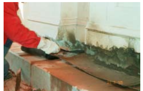
Ilægning af membran i spalte
